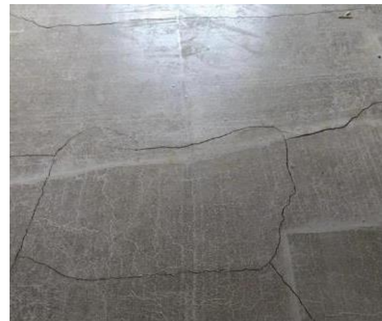
Smršťovací praskliny cementového potěru
