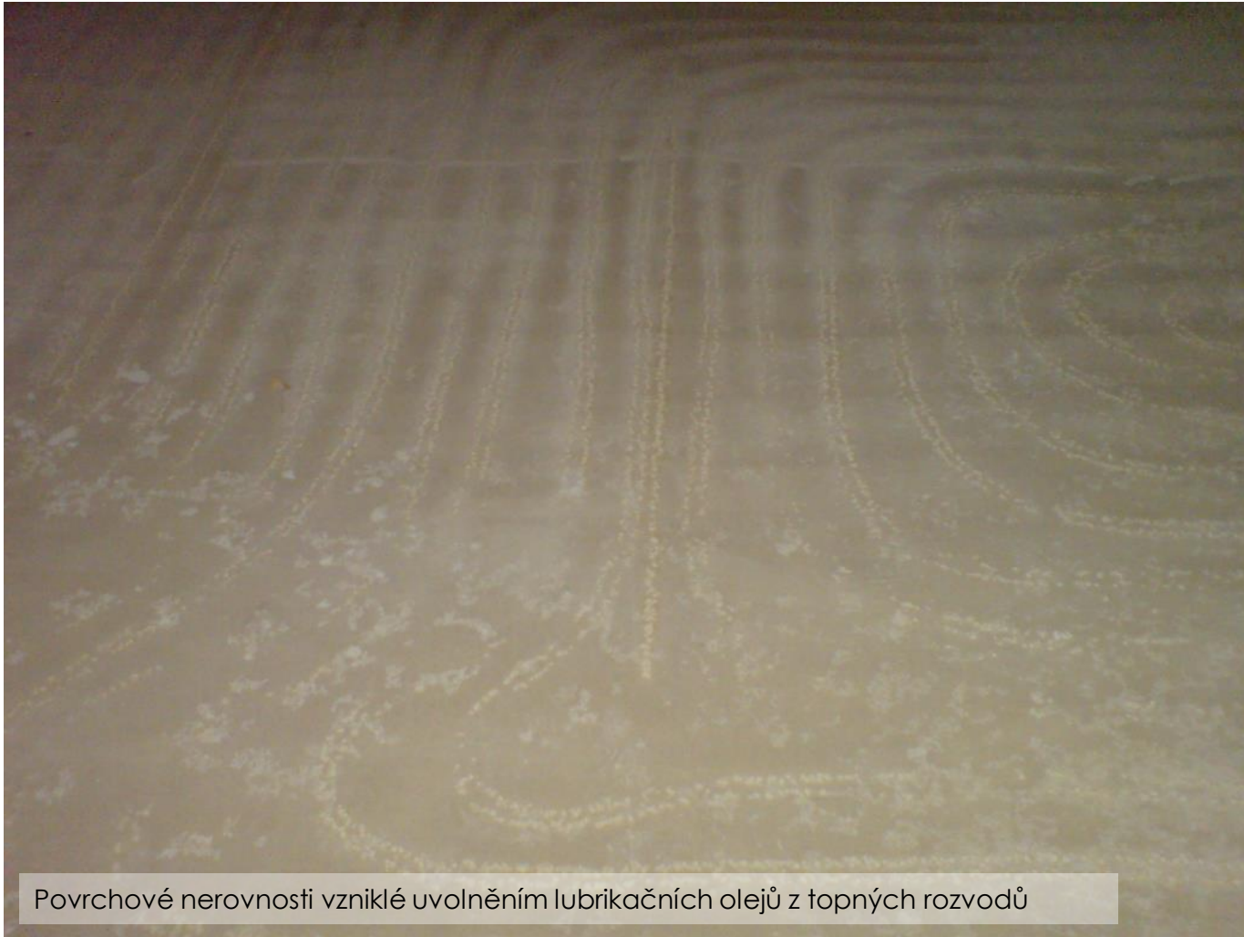
Nerovnosti povrchu v kombinaci se sintrem
