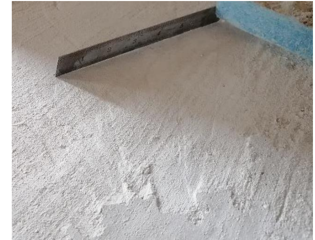
Nadměrné množství vody v anhydritu
