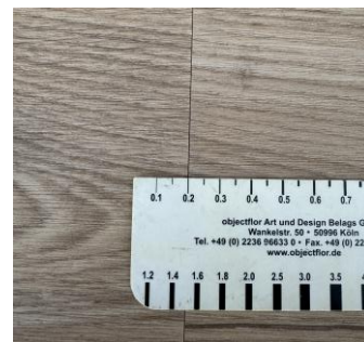
Projev vlhkostní expanze podkladu
