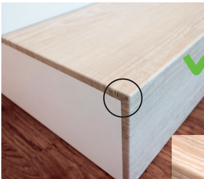
Detail zaoblění hrany schodu s nosem a lepená bočnice se stupněm.
